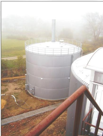
Nová čistírna odpadních vod pro Litvínov a okolní obce je mechanicko-biologická čistírna typu R-D-N s předřazenou usazovací nádrží, kompletním kalovým, plynovým a tepelným hospodářstvím. Akciová společnost K&H KINETIC se na realizaci podílela dodávkou, montáží a uvedením do provozu kalového, plynového a tepelného hospodářství.
